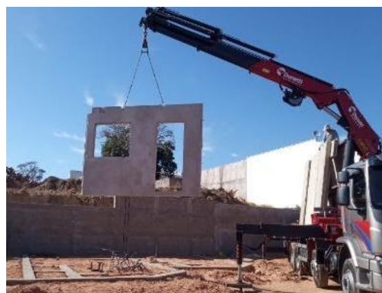
Movimentação de painéis para a montagem do pavimento térreo
