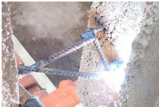
Soldagem entre três painéis
