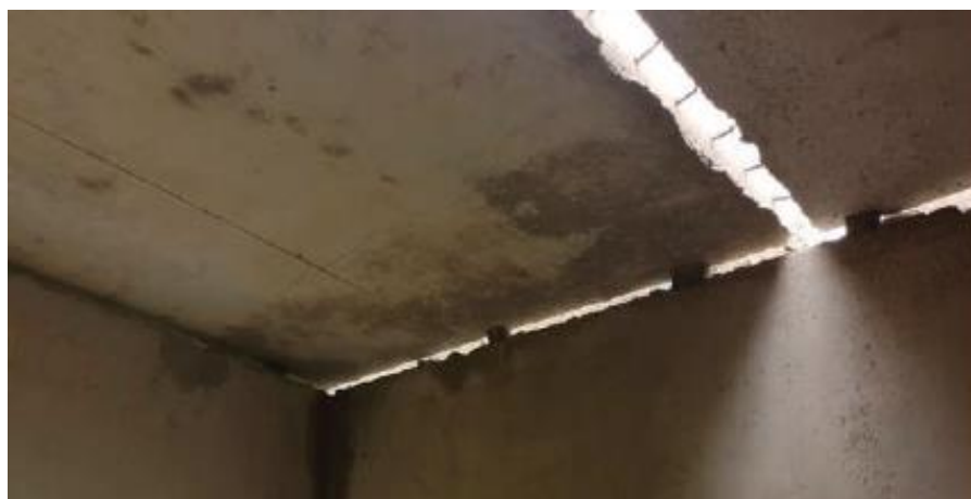
Figura 32 – Lajes pré-moldadas apoiadas sobre calços de argamassa de 3 cm de altura
