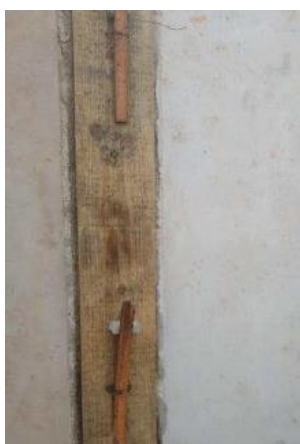
Fôrma de madeira amarrada no encontro entre painéis (esta fôrma pode ser substituída por fôrma metálica)
