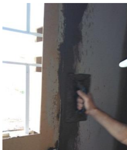
Revestimento do entorno da esquadria
