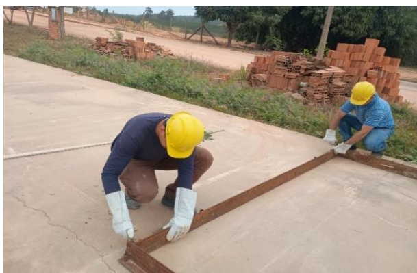
Montagem da fôrma
