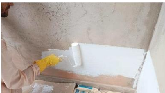
Figura 41 – Barrado com o sistema de pintura
