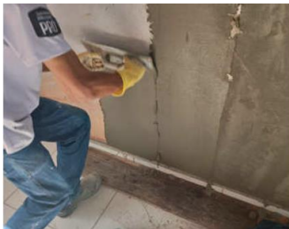
Figura 42 – Aplicação de argamassa colante AC-II em parede interna da edificação (Esta argamassa deverá ser lixada antes da aplicação da pintura)
