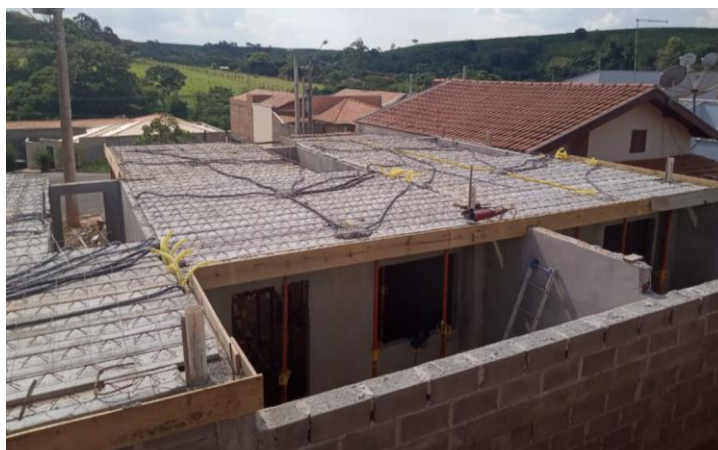
Figura 30 – Laje treliçada moldada no local
