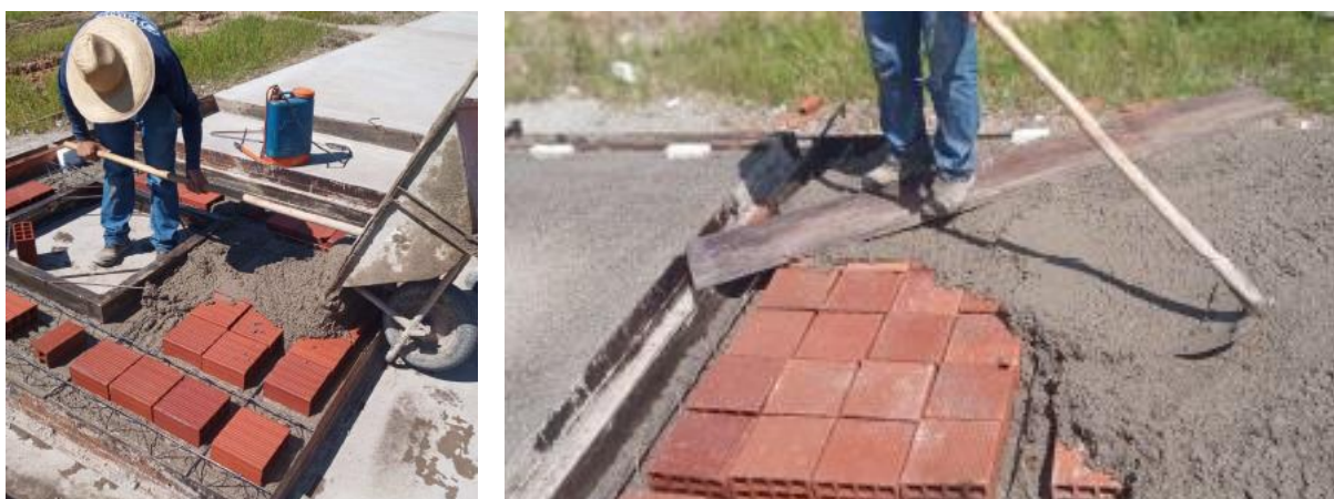
Figura 19 – Lançamento da segunda camada de concreto
