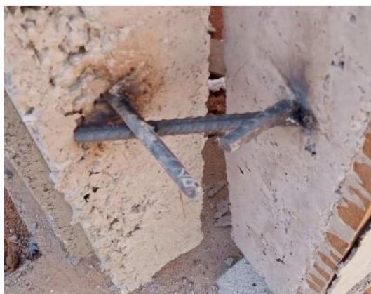
Soldagem entre dois painéis
