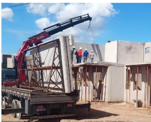
Movimentação de painéis para a montagem do pavimento superior
