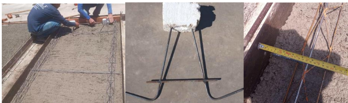
Posicionamento da armadura Posicionamento da alça de içamento Aferição das medidas
