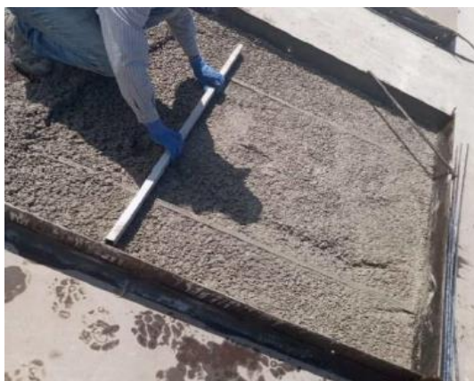
Sarrafeamento com régua de alumínio
