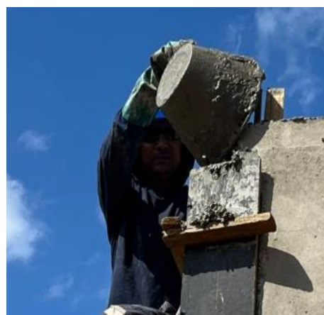
Fôrma e concretagem no encontro entre painéis
