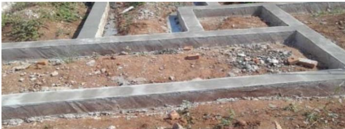
Figura 24 – Fundação executada para apoio dos painéis estruturais
