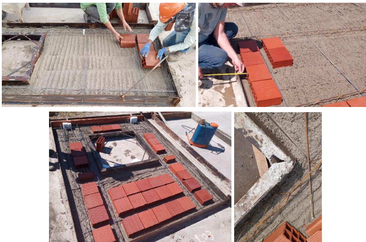
Figura 17 – Fotos do posicionamento dos blocos cerâmicos
