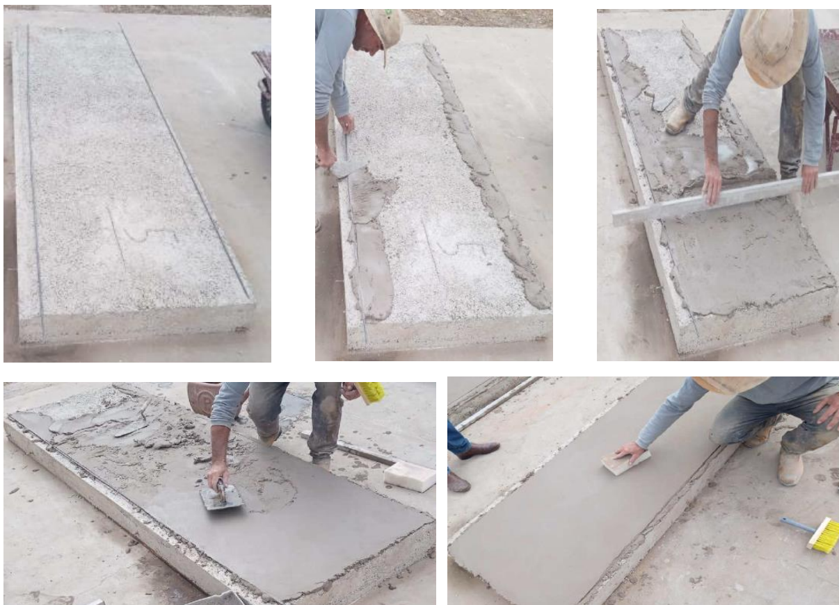
Figura 23 – Foto das etapas da execução do reboco
