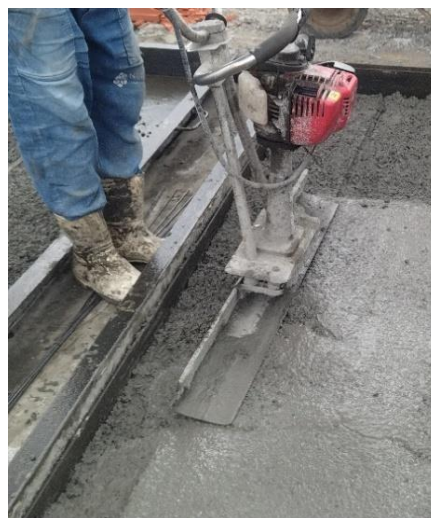
Adensamento do concreto com régua vibratória
