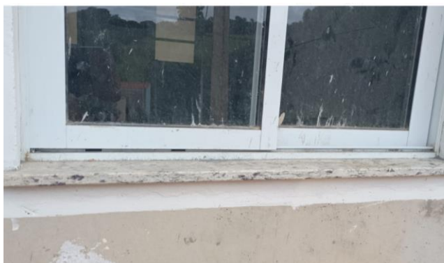
Figura 39 – Instalação de peitoril em granito
