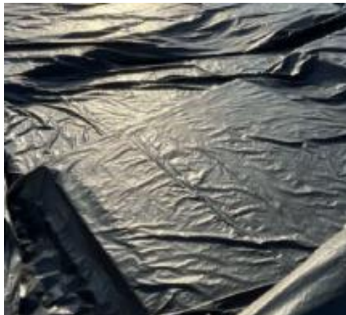
Figura 22 – cobertura com lona plástica para cura do concreto
