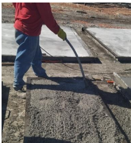
Figura 20 – Adensamento do concreto com vibrador de imersão
