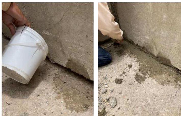
Figura 33 – Fotos da aplicação de argamassa na interface entre o painel superior e a laje de piso
