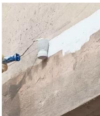
Figura 36 – Pintura da interface entre laje e painel
