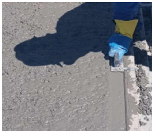
Figura 21 – Execução dos frisos
