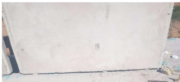
Figura 26 - Painel posicionado sobre calços de argamassa (exemplo de painel de 2,40 m com três calços)
