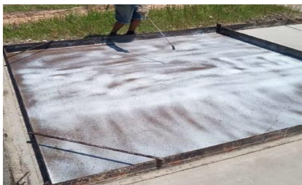
Aplicação de desmoldante
