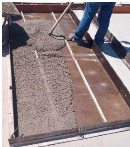
Lançamento da primeira camada de concreto
