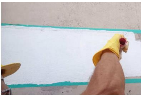
Figura 35 – Pintura da interface entre painéis sobrepostos
