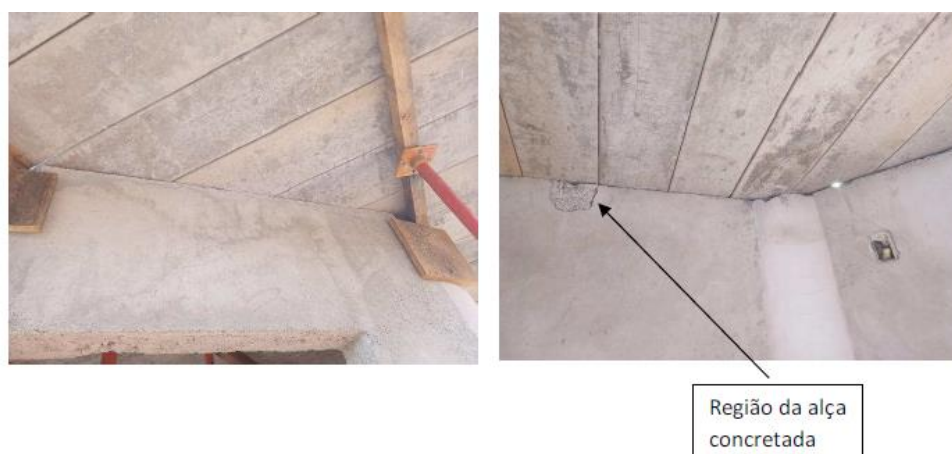
Figura 31 – Laje treliçada pré-moldada
