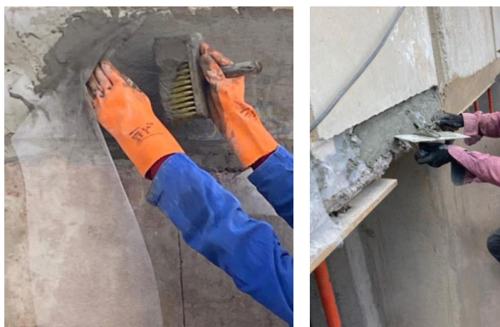
Figura 34 – Fotos da fixação da tela de poliéster horizontal entre painéis e lajes
