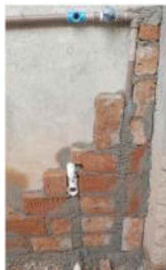
Fechamento de shaft com alvenaria
