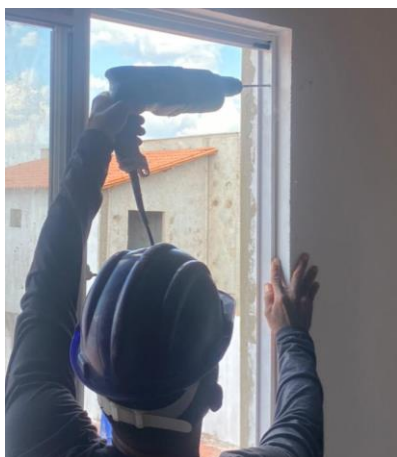
Figura 38 – Aparafusamento da esquadria
